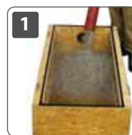
1 Открытая выдувка при помощи шланга
