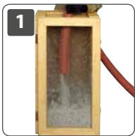
1 Verdichtetes Einblasen mit Schlauch
