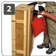
2 Verdichtetes Einblasen mit entlüfteter Drehdüse
