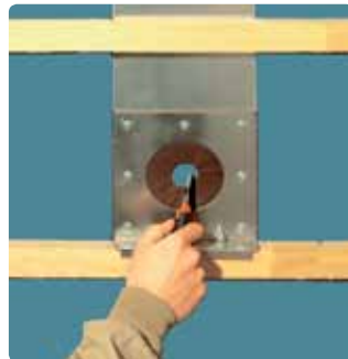
Herstellen der Einblasöffnung
