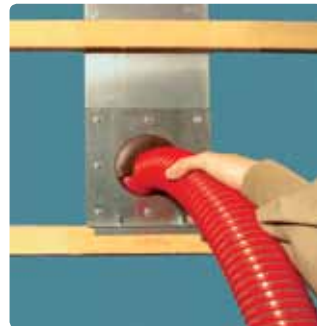
Einführen des Einblaschlauchs
